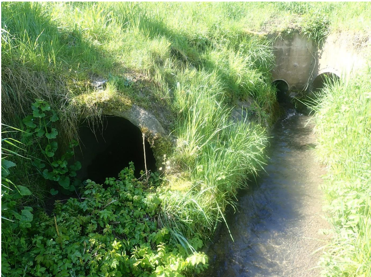
Abbildung 23: Einleitungsstelle des RÜB 4 Freibad Nordheim
