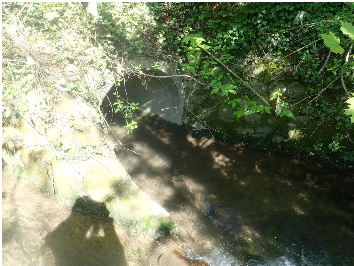
Abbildung 12: Einleitungsstelle des RÜB 5 Bahnhofstraße Nordheim
