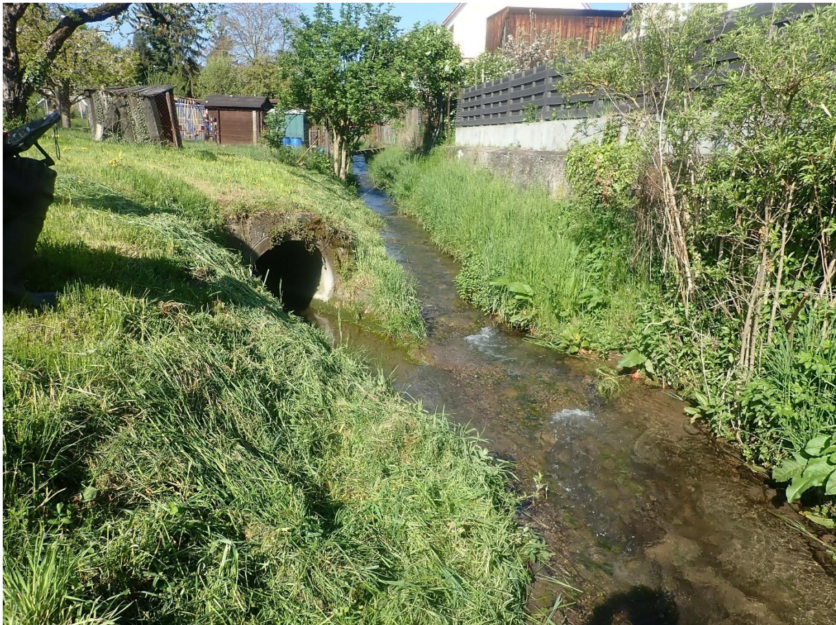
Abbildung 10: Einleitungsstelle des RÜB 2 Nordheim zweiter Beckenüberlauf
