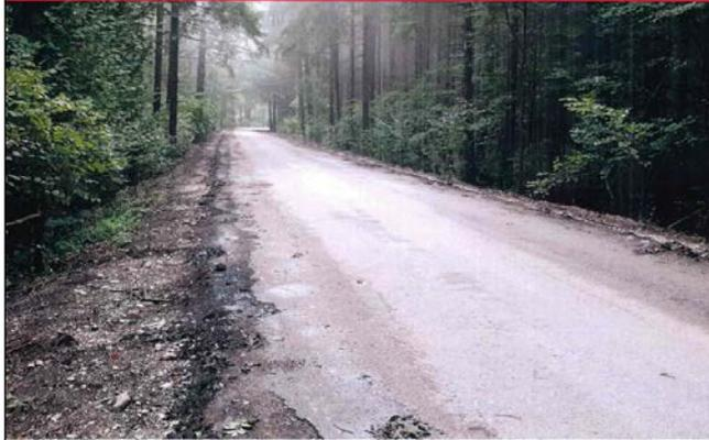
Abschieben der Humusränder im Bereich der Bankette mittels Grader oder Bagger.
