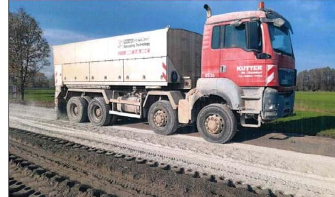
Ein selbstfahrender Bindemittelstreuer bringt computergesteuert die exakte, durch die Eignungsprüfung ermittelte Bindemittelmenge auf die Fahrbahn auf.
