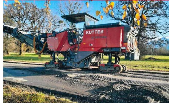
Granulieren der vorhandenen Asphalt-/ Betonschicht mittels Straßenfräse.
