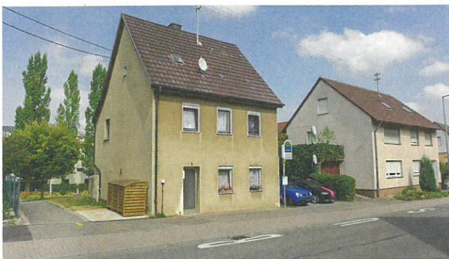
Die Gebäude Südstraße 2 und Südstraße 6 sind Teil der Entwicklungsfläche an dieser Stelle der Ortsmitte. Eine zeitgemäße Neubebauung – für was auch immer – wird den Abbruch dieser Gebäude notwendig machen.
