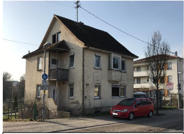
Gebäude Brackenheimer Str. 7 vor dem Abbruch 2026
