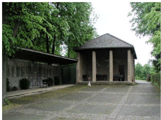
Die alte „Leichenhalle“
