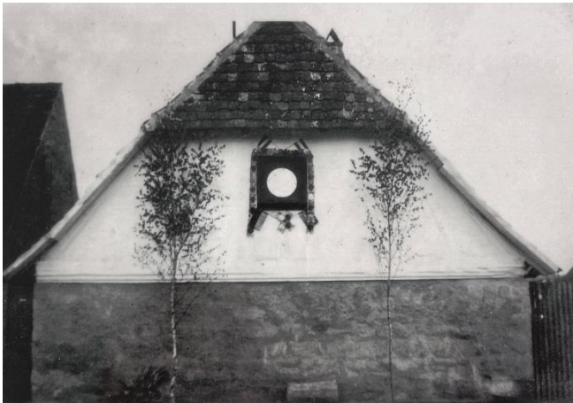
Das „Armenhaus“ in der Schwaigerner Straße vor dem Umbau 1948
