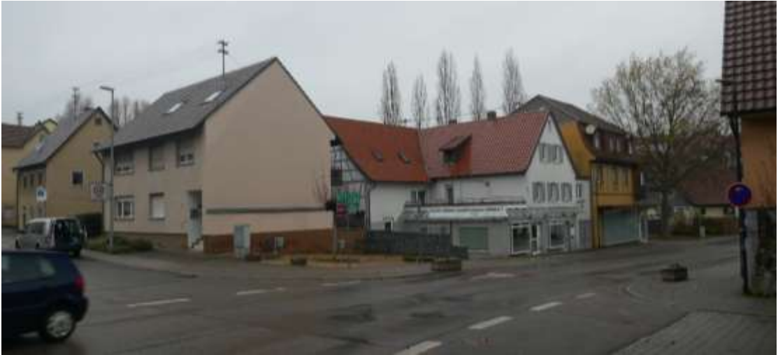
Blick zur Eckbebauung Südstraße / Lauffener Straße
