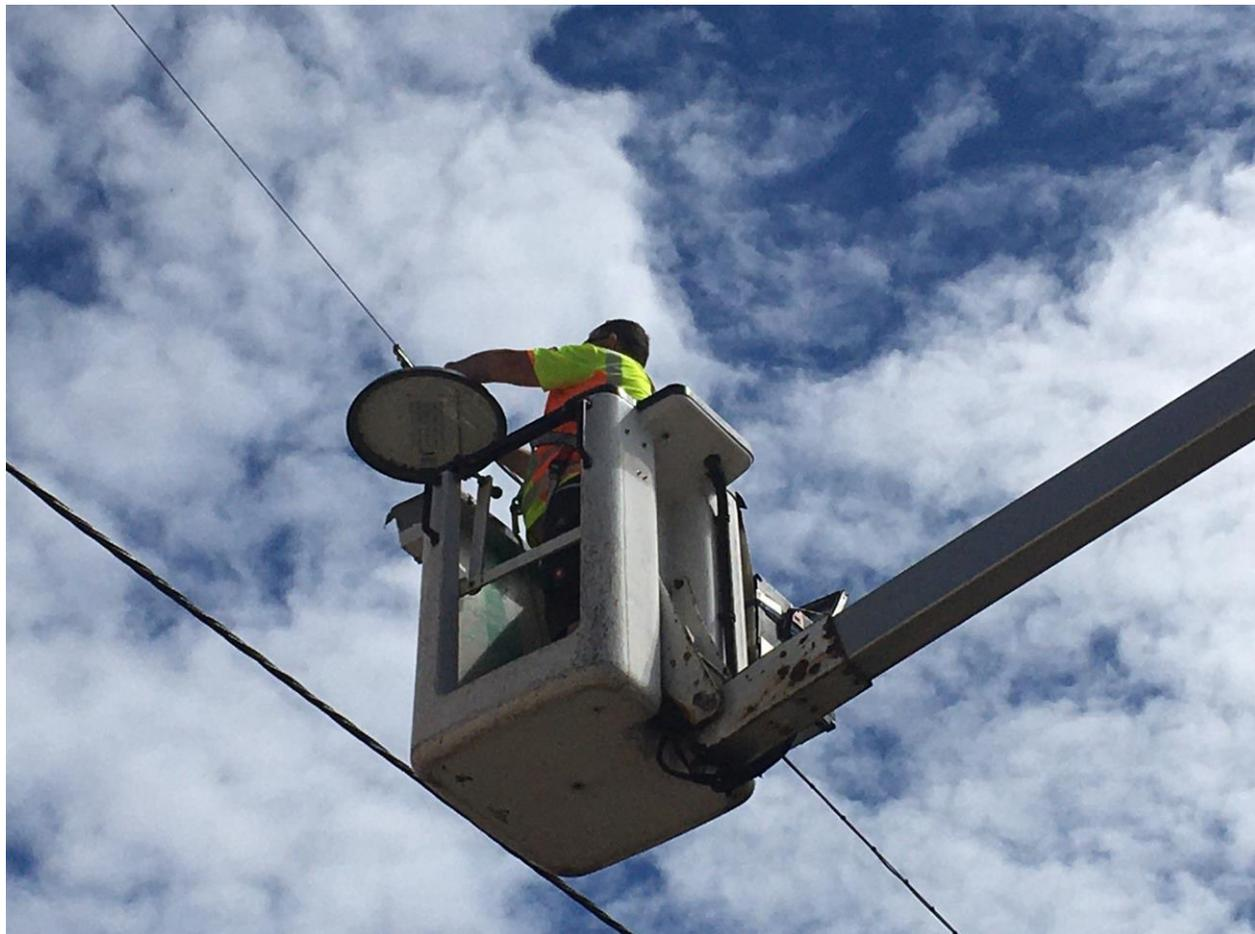
*Die alte Seilhängeleuchte wird vom Monteur abgehängt und durch eine Leuchte mit hocheffizienter LED-Technik ersetzt.*
