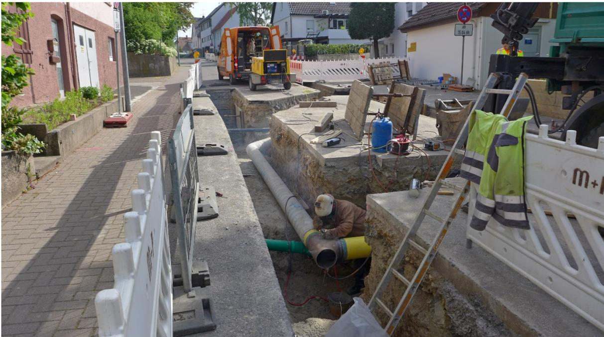
Vor der Erneuerung der Fahrbahn wurden zunächst erforderliche Arbeiten am gemeindlichen Wasserversorgungs- und Kanalnetz vorgenommen. Hierbei wurden Wasserleitungen sowie bei Bedarf auch Hausanschlussleitungen erneuert, die sich innerhalb der Ausbaustrecke befanden. Zudem wurden Kanalschächte saniert, soweit das notwendig war. Von der HNVG wurde eine bestehende Gasleitung ersetzt.
