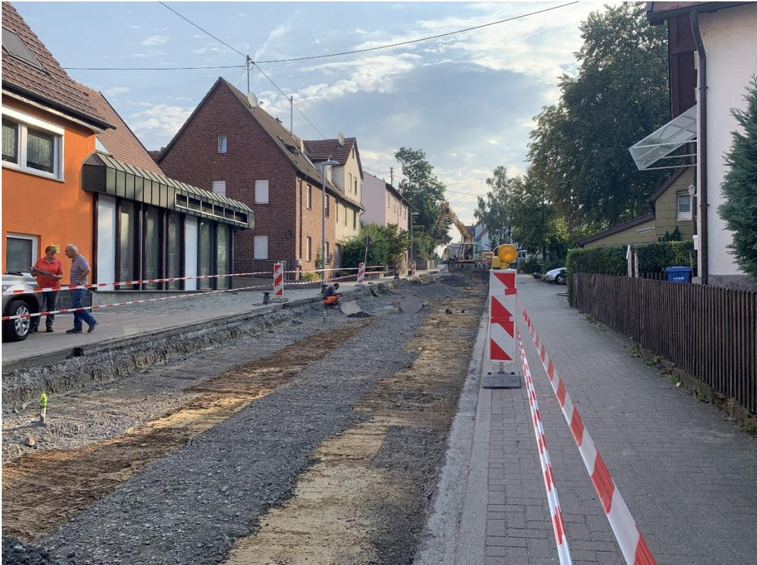
Nach den Leitungsarbeiten folgten die Straßenbauarbeiten von Ende Juli bis Ende November. So wurde die bestehende Asphaltdecksicht abgefräst und die Tragschicht abgetragen. Daraufhin wurde der Vollausbaubereich eingeschottert und im Anschluss eine Asphalttrag- und Binderschicht aufgetragen, auf welcher dann schlussendlich im gesamten Baufeld und in einem Zuge die Deckschicht aufgebracht wurde.
