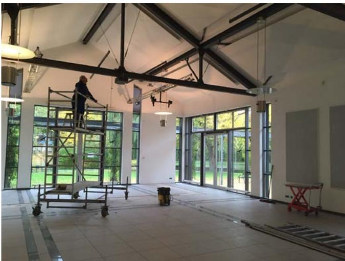
Soweit erforderlich wurden in den weiteren Räumen des Gemeindezentrums Trennwände ausgebaut und Flächen neu gestrichen. Am Dach wurden schadhafte Stellen abgedichtet.
