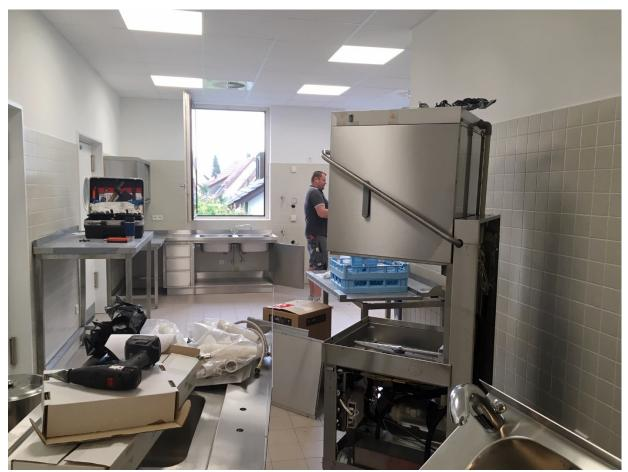
Im zuvor gefliesten Küchenbereich ist einiges los. Die Einrichtungsgegenstände werden zunächst an Ort und Stelle positioniert und anschließend verbaut. Durch eine umfangreiche Vorabstimmung war der Einbau in nur wenigen Tagen erledigt.
