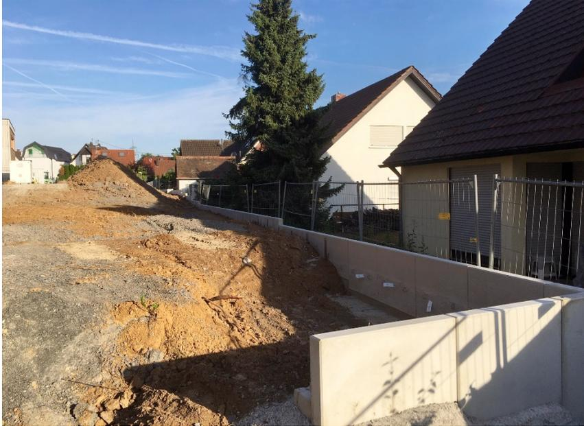
*Die Winkelstützwand ist gut sichtbar. Dahinter kann man die verfüllte Erde erkennen. In diesem Bereich wird die Außenspielfläche des Kindergartenneubaus entstehen.*
