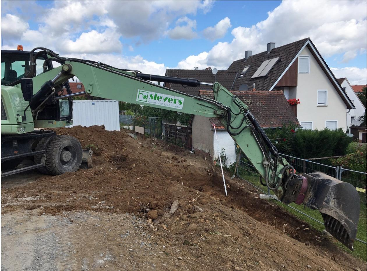
*Mit großem Gerät konnte die spätere Fläche für die Winkelstützen zügig präpariert werden. Mit Hilfe eines Lasers ist das höhengenaue Versetzen der großen Betonfertigteile möglich.*
