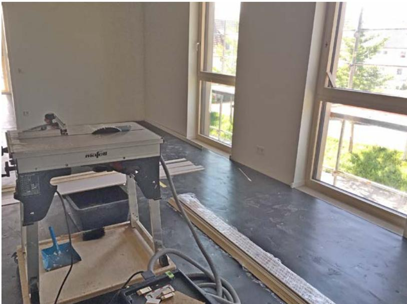
*Der Schutzbelag auf dem Kautschukboden ist gut zu erkennen, ebenso die ersten Fußbodenleisten an den Übergängen zur Wand.*
