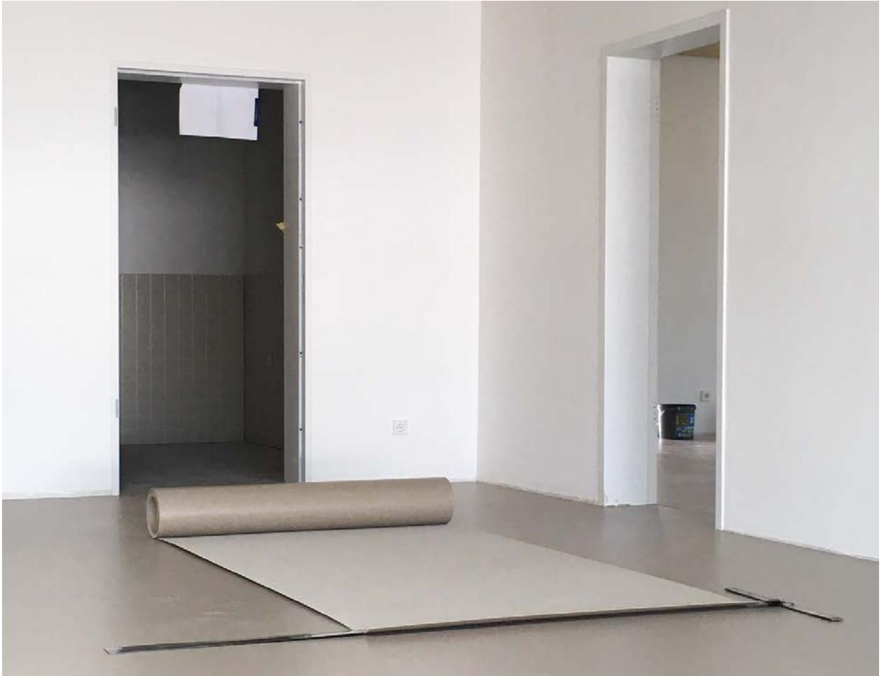
*Im Flur ist der Boden bereits fertig verklebt. Durch die äußerst präzisen Verlegearbeiten lassen sich die Fugen nicht mehr erkennen. Hier sieht man noch eine der zahlreichen Rollen, auf denen die Kautschukbahnen als Meterware angeliefert wurden.*
