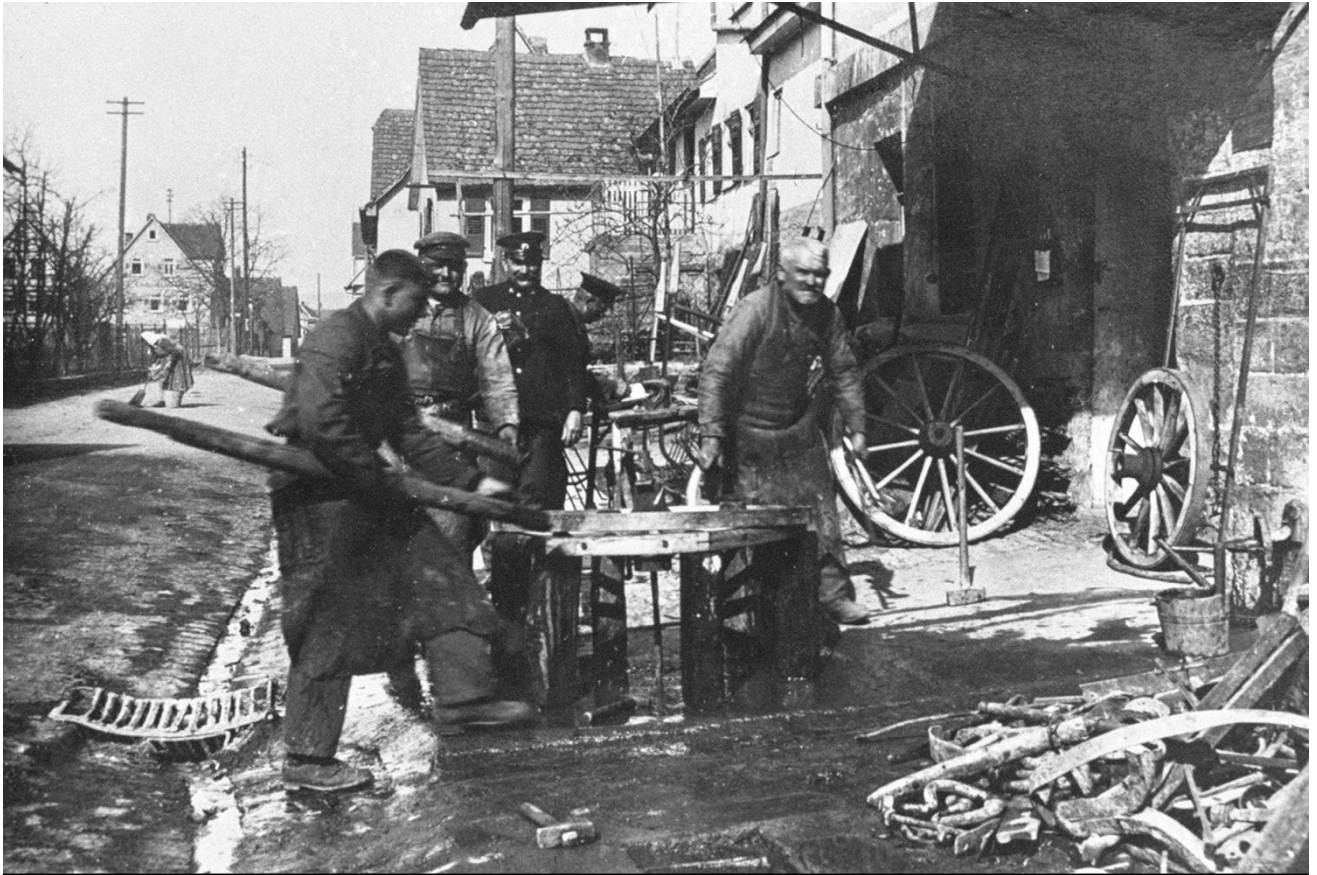
Aufziehen eines Eisenreifens auf ein Wagenrad in der Schmiede von Jakob Frank
