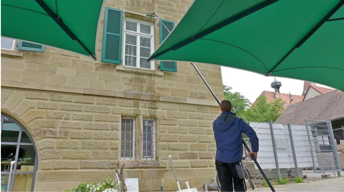
*Der Teleskopstab ermöglicht eine Reinigung auch vom Boden aus. Ein Gerüst oder eine Leiter wird nicht benötigt.*
