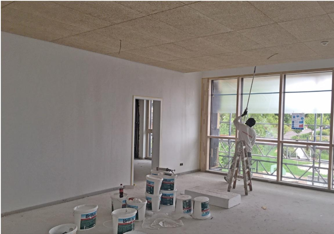
*Die ersten gestrichenen Wände sind bereits sichtbar. Große Flächen werden mit der Malerwalze gestrichen. Für die Feinarbeiten an den Fenstern und Ecken kommt der Pinsel zum Einsatz.*
