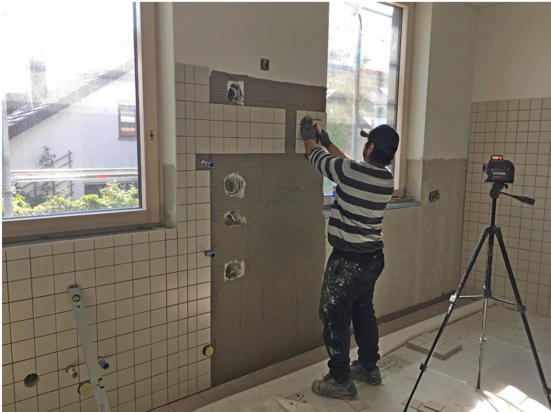
*Die Arbeiter verkleben die Mosaiknetze auf den bereits aufgetragenen Fliesenkleber. Für die Ausrichtung der Fliesen wird ein Laser benutzt. Dieser projiziert eine rote Laserlinie auf die Wand, an der sich der Fliesenleger orientieren kann.*
