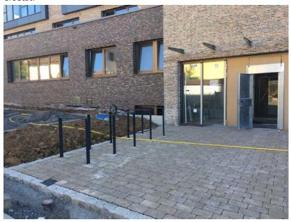
Die Pflasterfläche am Hintereingang ist bereits sichtbar. Ebenso die 5 versetzten Fahrradständer aus Flachstahl. Die Pflanzbete zwischen der Eingangsfläche und dem Parkplatz werden nun nach und nach mit Erde befüllt. Die Bepflanzung soll in den kommenden Wochen folgen.
