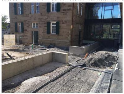
Die Ortbetonwände sind gut zu erkennen. Zwischen den beiden Wänden wird eine Treppe erstellt.
