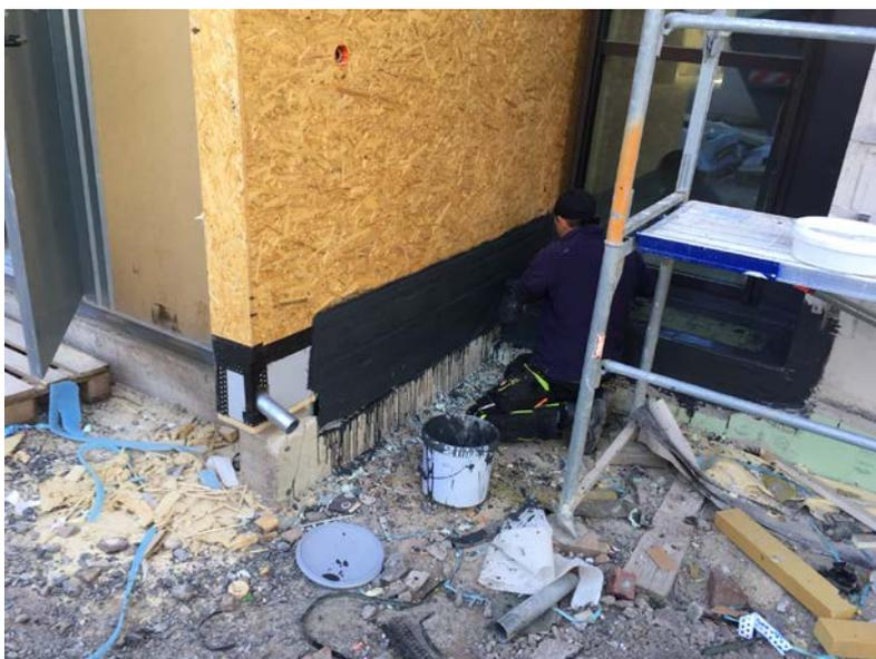
*Der Übergang zwischen Windfang und Untergrund ist gut zu erkennen. Die einzelnen Bahnen werden von Hand aufgebracht und glattgestrichen. Durch die hohe Flexibilität der Materialien können so auch komplexe An- und Abschlüsse abgedichtet werden.*
