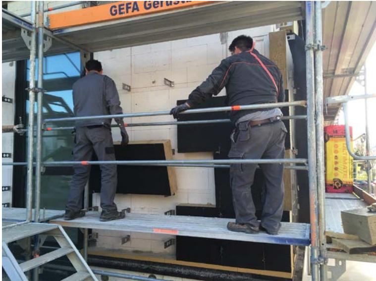
*Die Arbeiter schneiden die mineralischen Dämmplatten zurecht. Diese bestehen aus formstabiler Steinwolle mit einseitiger Vlieskaschierung. Die später aufgebrachte Aluminiumvorhangfassade ist somit stets hinterlüftet. Zwischen dem mineralischen Dämmsystem und der Perimeterdämmung wurde bereits das umlaufende Gesimsblech installiert.*
