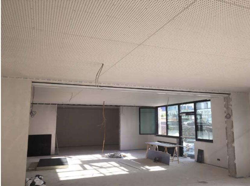
*Die einzelnen Platten sind noch gut erkennbar. Ebenso die bereits gesetzten Lampenauslässe. Am Übergang zu den Raumwänden wird ein Trennstreifen eingelegt. Dieser Spezialpapierstreifen sorgt für eine effektive Bauteilabtrennung zwischen abgehängter Decke und Wand. In den folgenden Wochen werden die Wände und Decken vom Maler gestrichen.*
