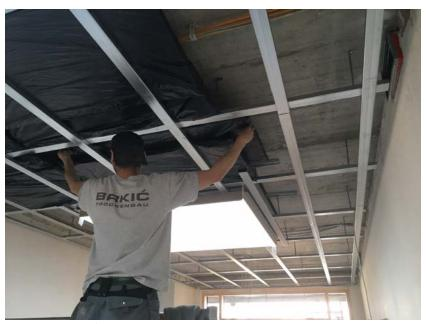
Die Deckenprofile der Unterkonstruktion sind sichtbar. Die Mitarbeiter der Trockenbaufirma legen die schwarzen Schalldämmmatten auf die Unterkonstruktion auf. Wichtig ist eine geringfügige Überlappung um die bestmögliche Schallabsorption zu gewährleisten.
