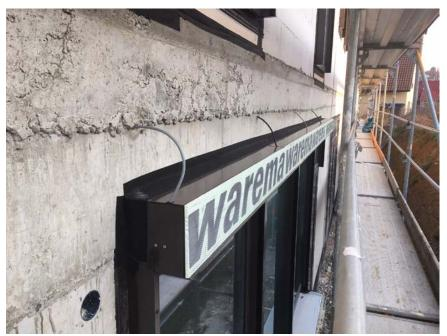
Die Fassadenmarkisen der Firma Warema sind gut sichtbar. Jedes Fensterelement wird separat gesteuert. Damit kann optimal auf die entsprechenden Lichtverhältnisse reagiert werden.
