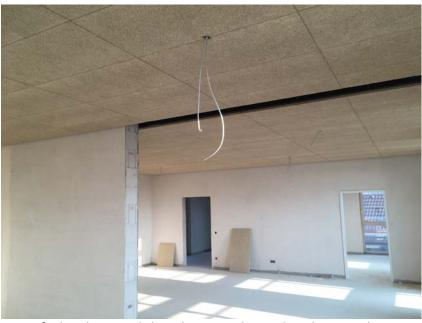
Die aufgebrachten Leichtbauplatten sind gut erkennbar. Um den Innenraum freundlich und hell wirken zu lassen, ist die Farbwahl auf einen beige farbenen Ton gefallen. Zwischen den Gruppenräumen wird noch eine faltbare Trennwand installiert.
