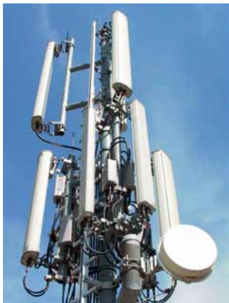
Mobilfunkmast mit Antennen verschiedener Betreiber. Im Bild unten rechts: eine Richtantenne zur Anbindung an die übergeordnete Netzeinheit. Quelle: LUBW
