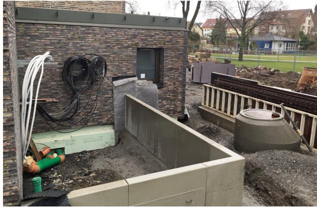
Im vorderen Bereich sind die versetzten Mauerscheiben gut sichtbar. Die metrigen Elemente wurde mit Trockenbeton an Ort und Stelle verbaut. Im rückwärtigen Bereich ist die Sichtbetonschalung zu erkennen. Die benötigte Stahlbewehrung ist bereits eingebracht.
