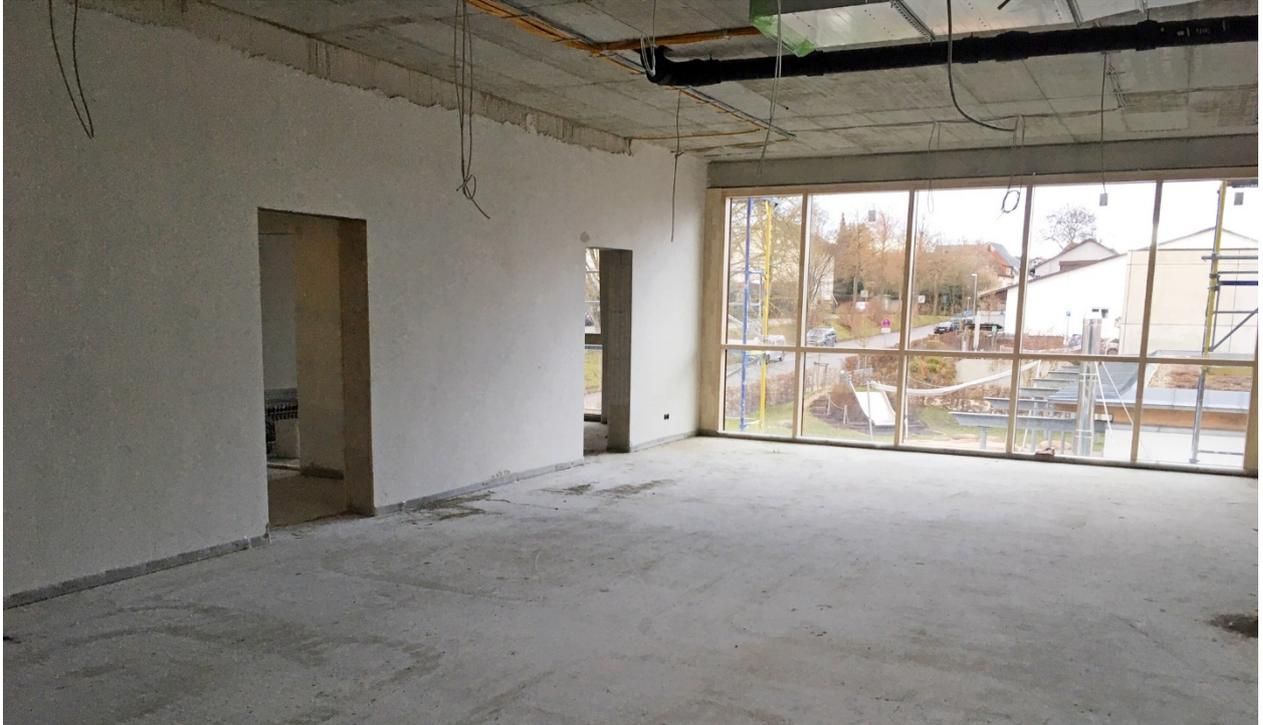
*Der eingebrachte Estrich ist gut zu erkennen. Ebenfalls sichtbar die Installationsarbeiten an den Decken. Die Pfosten-Riegelfassade sorgt für viel Tageslicht im Gebäudeinneren.*
