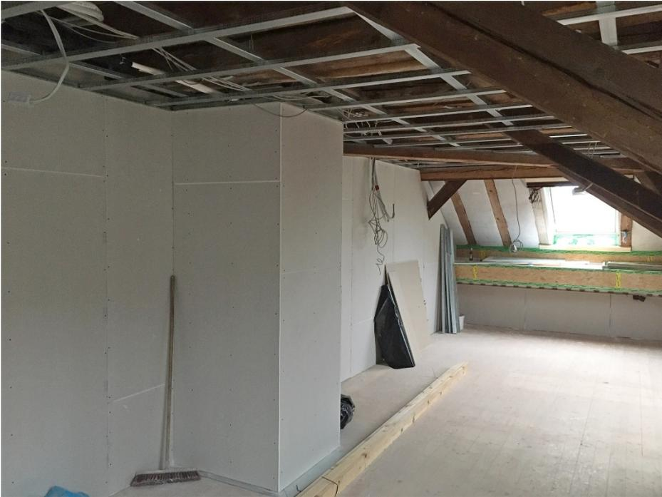
*Die beplankten Wände sind bereits fertiggestellt und werden noch verspachtelt. Die Deckenkonstruktion ist bereits aufgebracht. Anschließend wird die Konstruktion mit Gipskartonplatten versehen. Das Gebälk soll sichtbar bleiben.*
