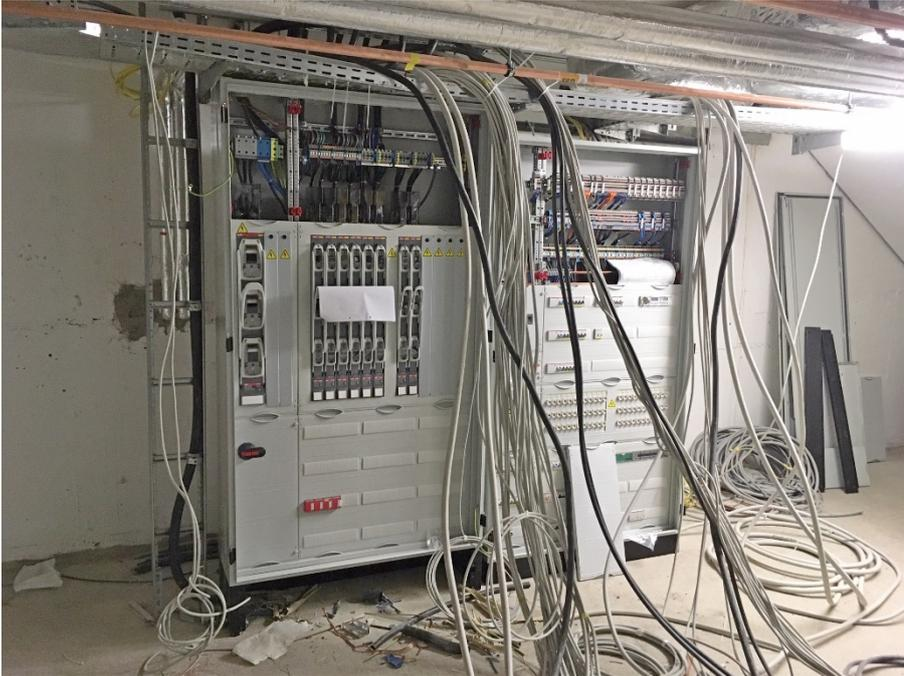
*Die zwei raumhohen Schaltschränke sind gut zu erkennen. Die ersten Sicherungen sind bereits montiert. Ein Großteil der Leitungen ist schon im Schaltschrank verklemmt.*
