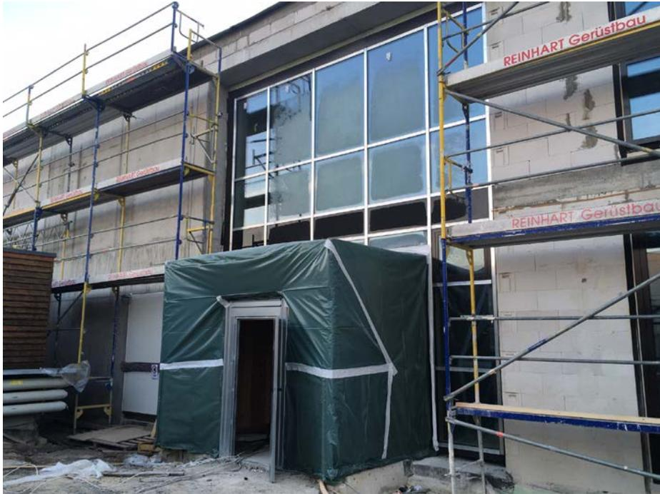
*Der abgedeckte Windfang ist gut zu erkennen. Im weiteren Ausbau werden zwei Schiebetüren eingebaut. Die großen Fensterflächen der Pfosten-Riegelfassade sorgen für viel Tageslicht im Gebäudeinneren.*
