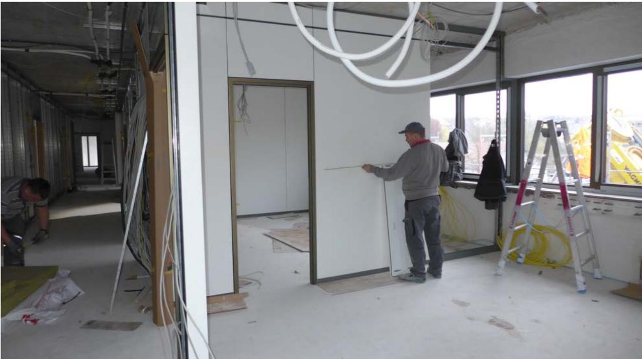
*Die Stahlrahmenkonstruktion wird beplankt. Die Zwischentüren sind sichtbar.*
