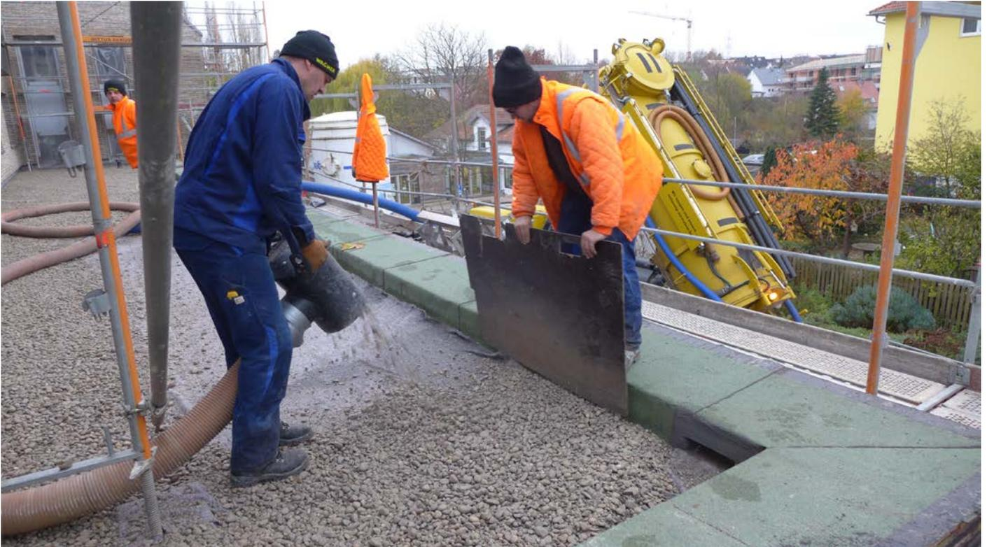
*Der Kies wird mit Hilfe eines Saugwagens auf das Flachdach befördert. Mit dem flexiblen Rohr kann der Kies punktgenau und in der gewünschten Stärke auf das Dach eingebracht werden.*
