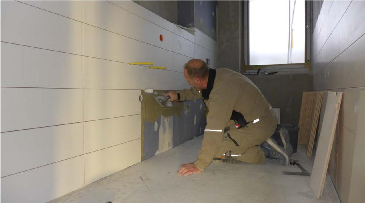
*Der Fliesenkleber wird mit einer Zahnkelle aufgetragen. Der Fliesenspiegel und das Fugenbild sind gut zu erkennen.*
