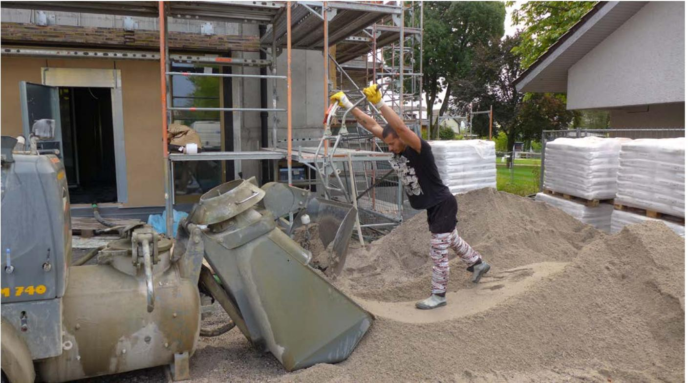
*Die Estrichmaschine wird mit dem entsprechendem Sand-/Zementgemisch bestückt. Die Materialien werden mit einem Schieber in den Einfülltrichter geschoben.*
