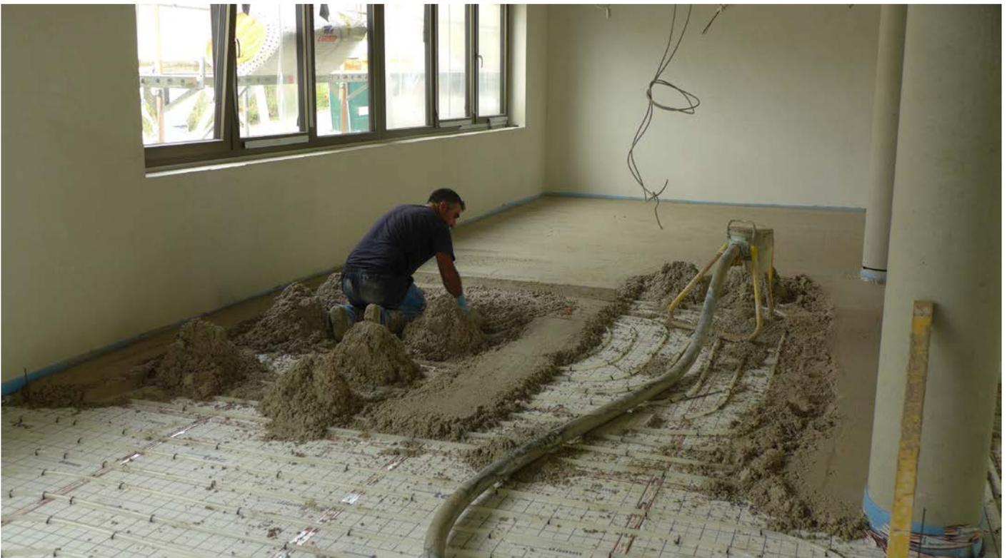
*Der Baustellenestrich wird dann unter Zugabe von Wasser durch die Maschine angerührt und mit Schläuchen eingebracht. Anschließend wird der Estrich lotrecht abgezogen.*
