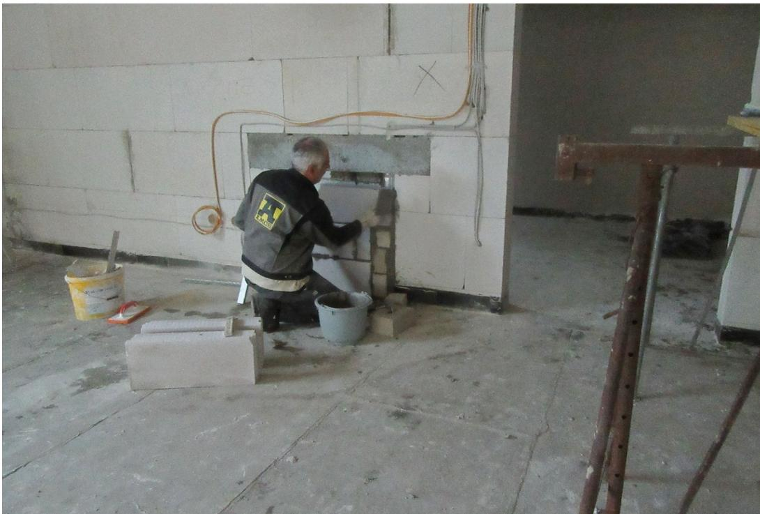
*Öffnungen werden mit Mauersteinen und Mörtel verschlossen.*
