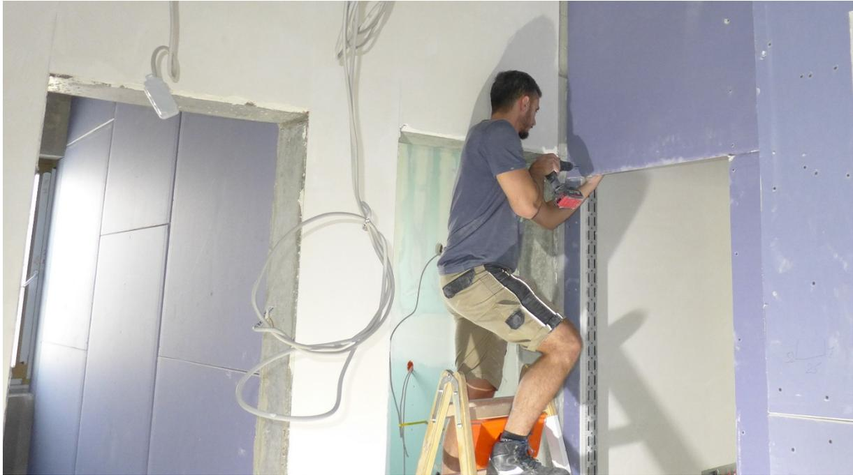
*In den Nebenräumen werden die Zwischenwände in Trockenbauweise hergestellt. Gipstafel um Gipstafel wird angebracht, bis die Wand fertig ist zum Verspachteln.*
