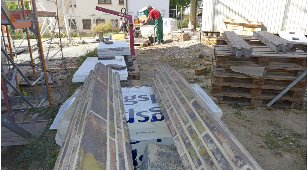
*Die allermeisten der Klinkersteine werden einzeln in die Hand genommen und an ihren Platz gesetzt. Im Hintergrund sägt ein Mitarbeiter Steine zurecht, während im Vordergrund einige der wenigen vorgefertigten Teile zu erkennen sind, die z.B. im Bereich von Fensterstürzen, Ecken und Abschlüssen in die Fassade integriert werden.*
