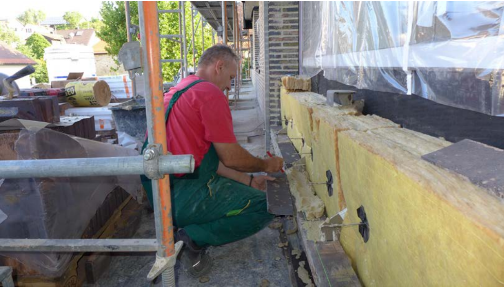
Fachleute bei der Arbeit. Für die Klinkerfassade wird sehr genau gearbeitet. Gut zu erkennen auch die hinter den Klinkern befestigte Dämmung.
