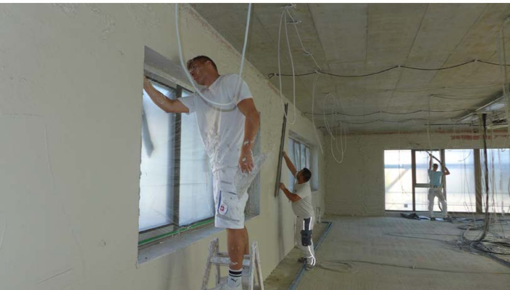
Hier werden die Innenwände im Obergeschoss des Neubaus verputzt. Die Einteilung der Räume erfolgt später durch System-Trennwände.
