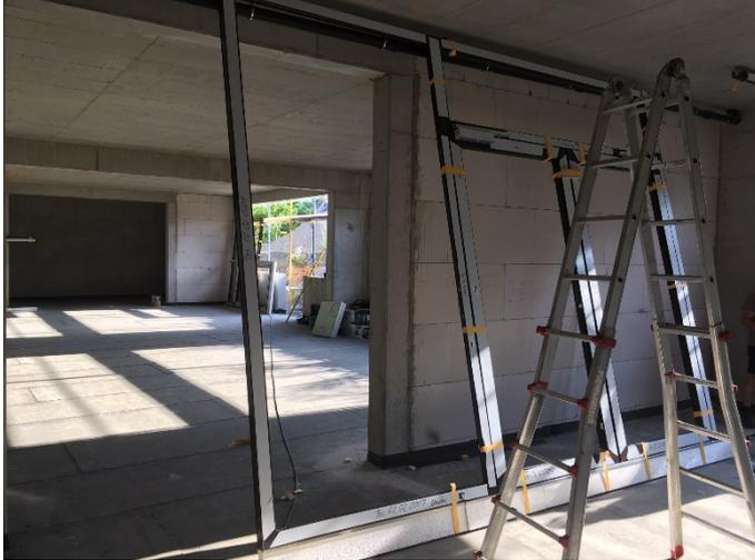
*Die Aluminiumprofile der Pfosten-Riegelfassade sind gut erkennbar.*
