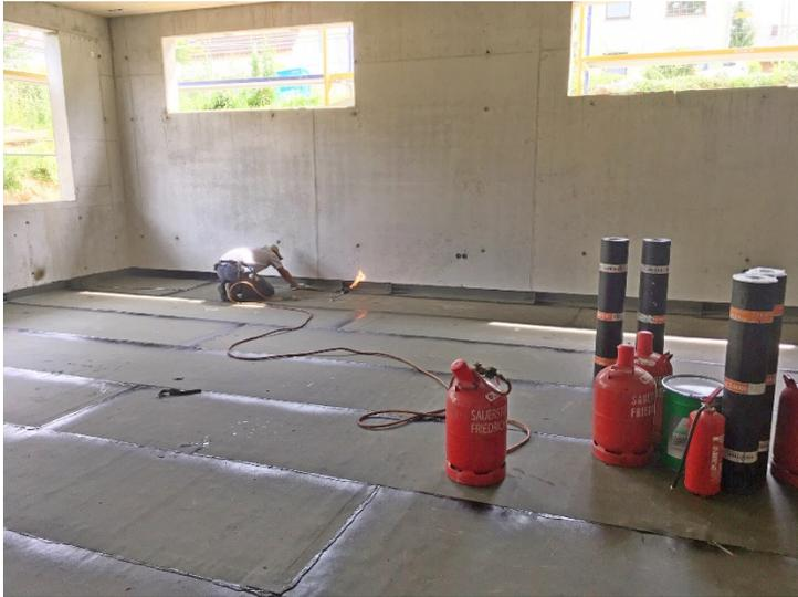
*Die bituminösen Schweißbahnen werden mit Hilfe eines Gasbrenners aufgebracht.*
