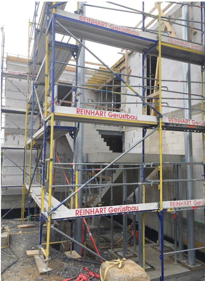
*Die Treppenläufe sind sichtbar. Ebenso sind die Podeste und die Stahlkonstruktion zu erkennen.*
