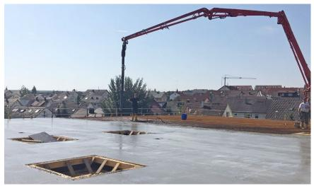
Der nördliche Teil der Decke ist schon betoniert. Am südlichen Ende wird der Beton mit der Betonpumpe eingebracht.
