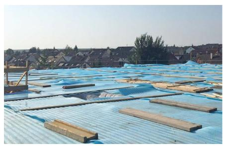
Die blaue Folie deckt den Beton vollflächig ab und schützt so vor den hohen Temperaturen und der direkten Sonneneinstrahlung.
