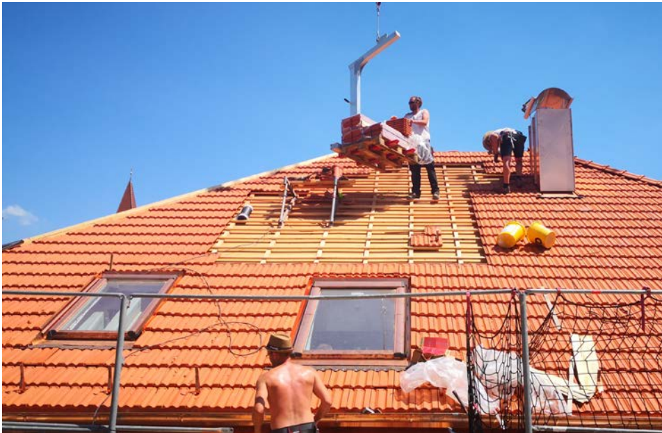
Das Dach am historischen Rathaus ist beinah fertig.
