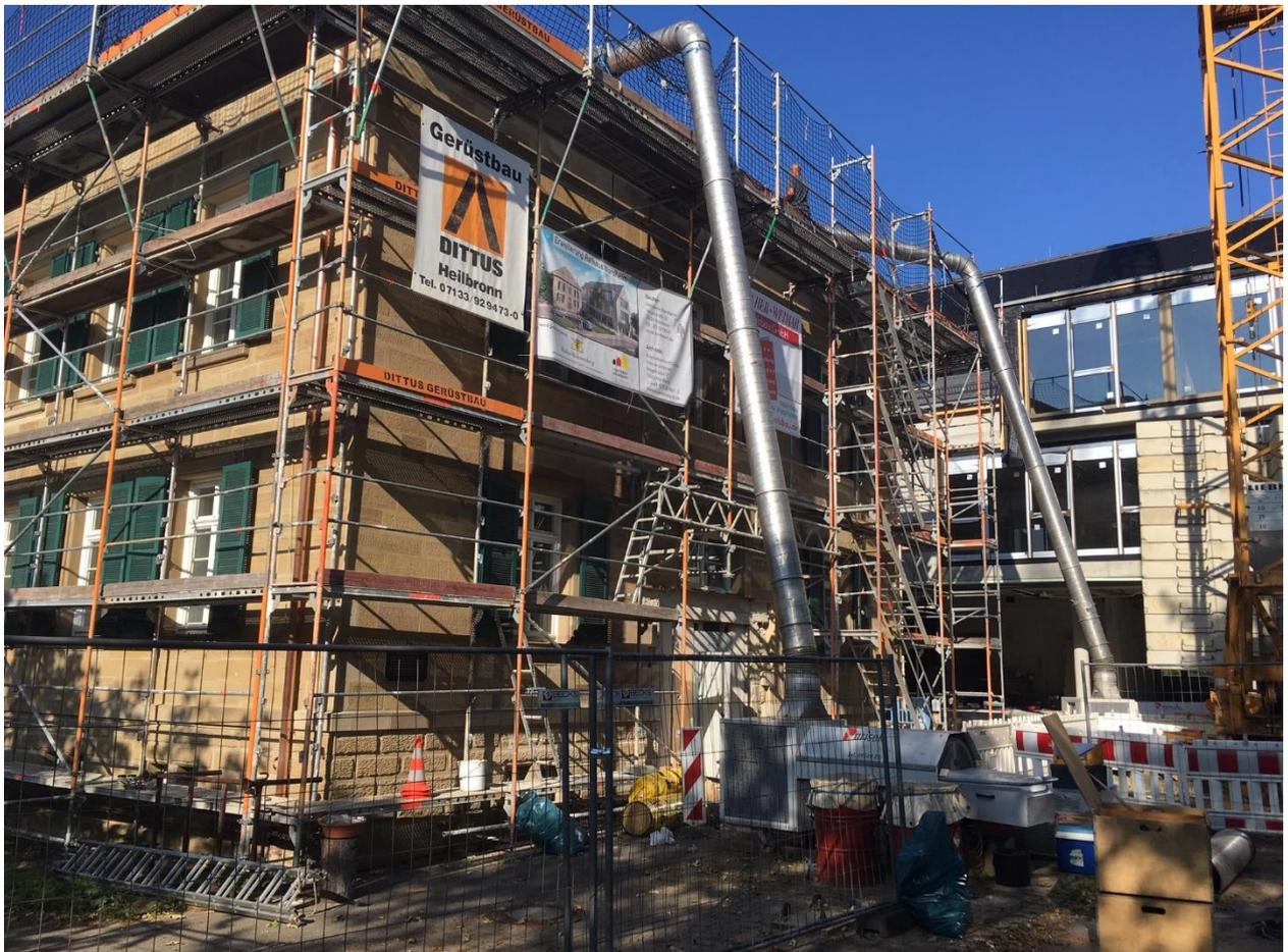
*Unser Bild zeigt die beiden Ölgebläse, mit denen die erzeugte Warmluft über die Heizrohre in das Dachgeschoss eingeblasen wurde.*
