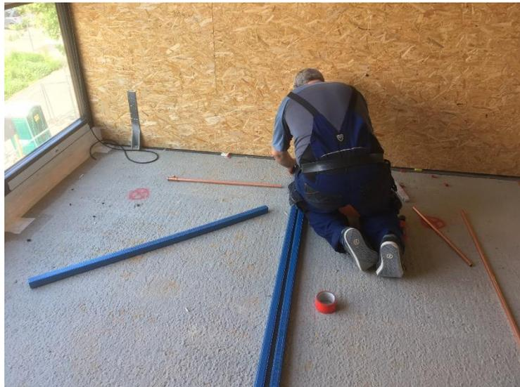
*„Verlauf der Heizungsrohre im Dachgeschoss des Neubaus“*
