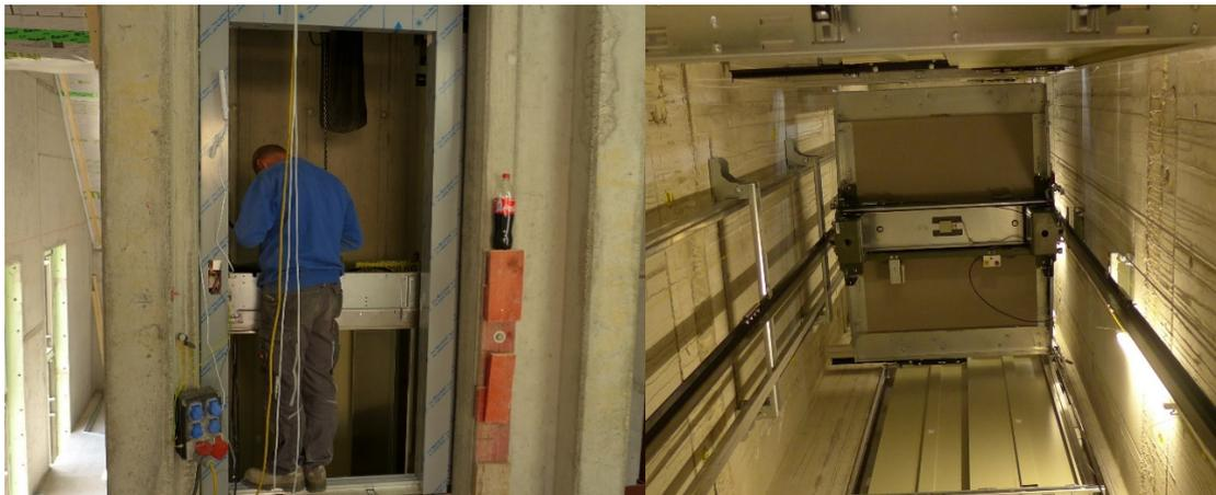
*Montage des Aufzugs im Rathausneubau. Die Aufzugskabine ist bereits eingebaut.*
