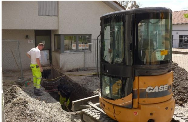
*Zwischen dem Neubau und den Bestandsgebäuden werden Versorgungsrohre verlegt, z.B. für Wasser, Strom, Wärme, Gas, EDV, ...*
