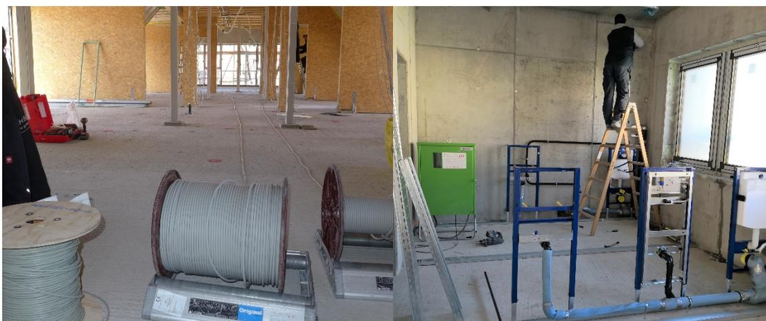
*Unglaubliche Längen an Kabeln und Rohren sind zu verlegen. Elektro-, Sanitär- und Lüftungsanlagenarbeiten laufen parallel*
