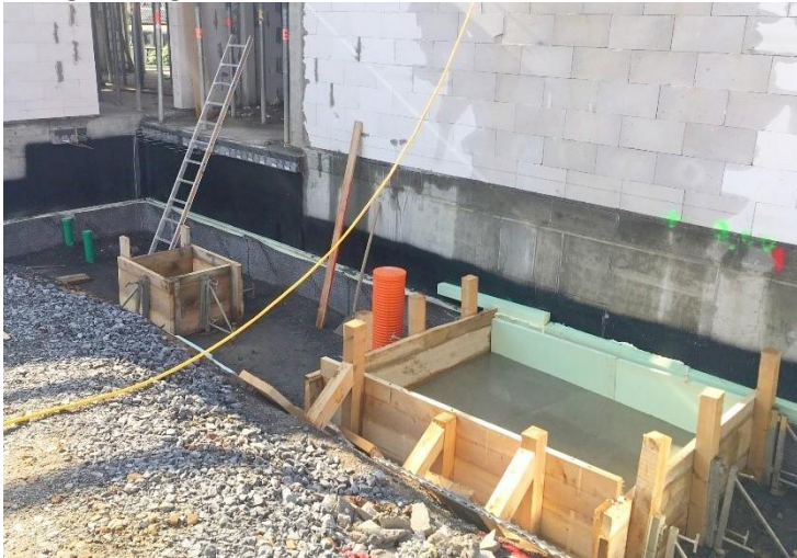
Die Fundamente wurden geschalt und mit Beton ausgegossen.
