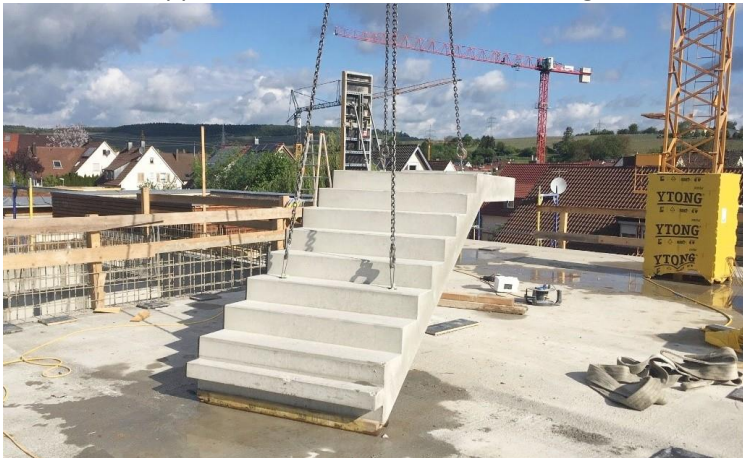
Betonfertigtreppe vor dem Einbau in das Treppenhaus.
