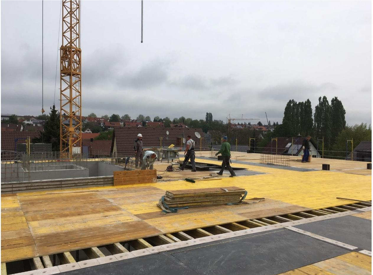
*Das Treppenhaus und der Aufzugsschacht sind am linken Bildrand erkennbar. Der restliche Bereich der Decke wird mit Schaltafeln ausgelegt.*
