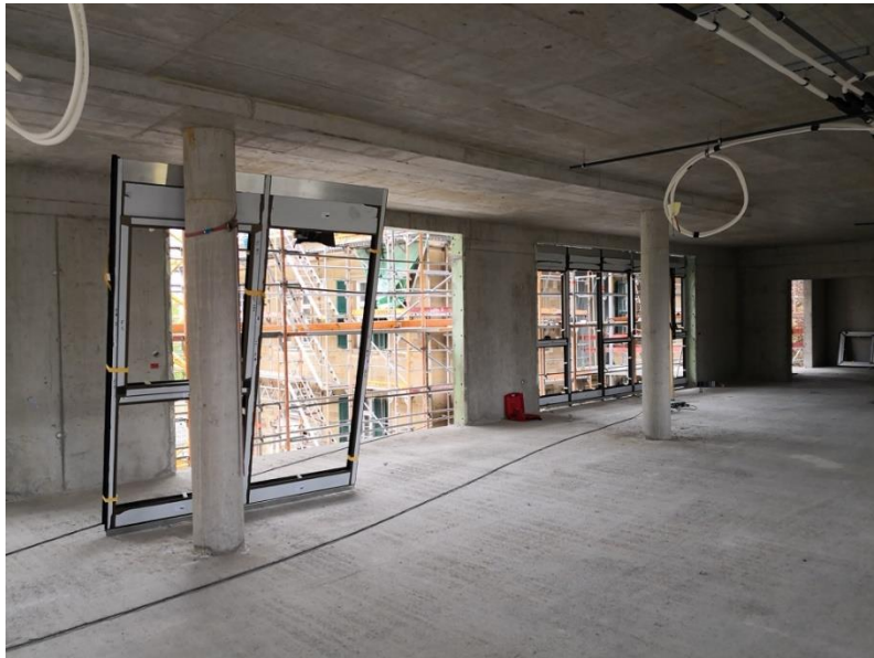
Einbau der Fenster im Rathausneubau
