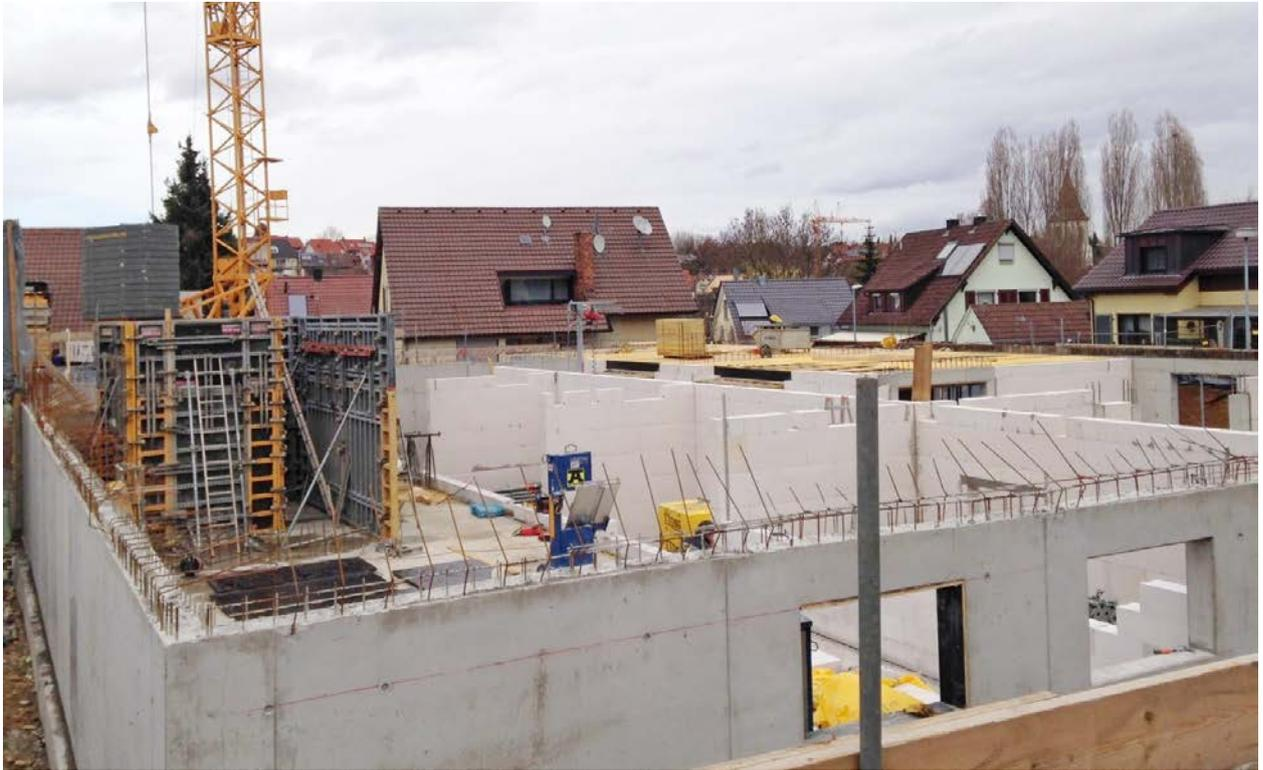
*Der Gebäudeumriss des Untergeschosses ist nun vollständig erkennbar. Ebenso lassen sich erste Raumaufteilungen erahnen. Die Schalungsarbeiten für die Geschosdecke sind im rückwärtigen Teil der Baustelle sichtbar.*
