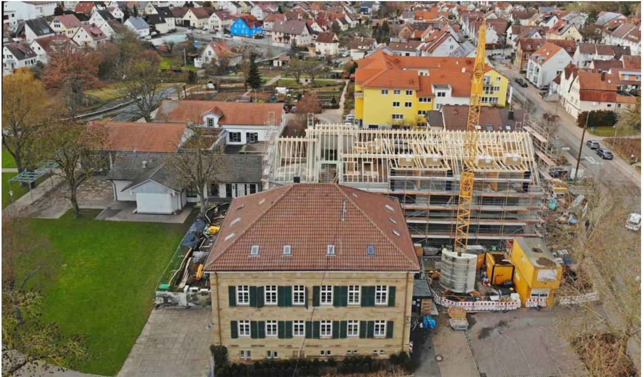
Der Rohbau ist soweit fertiggestellt, dass der Zimmermann den Dachstuhl für den Rathausneubau aufstellen konnte. Entsprechend der Tradition findet das
