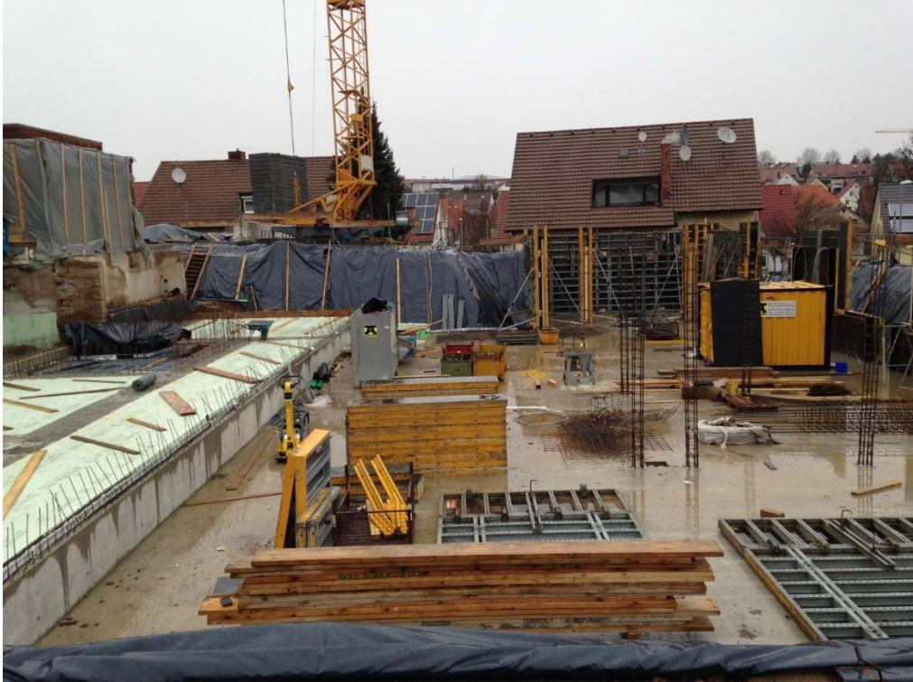
*Auf dem Bild ist die Bodenplatte des Neubaus gut erkennbar. Seitlich sind die ersten Schalelemente für die Außenwände in Stellung gebracht.*
