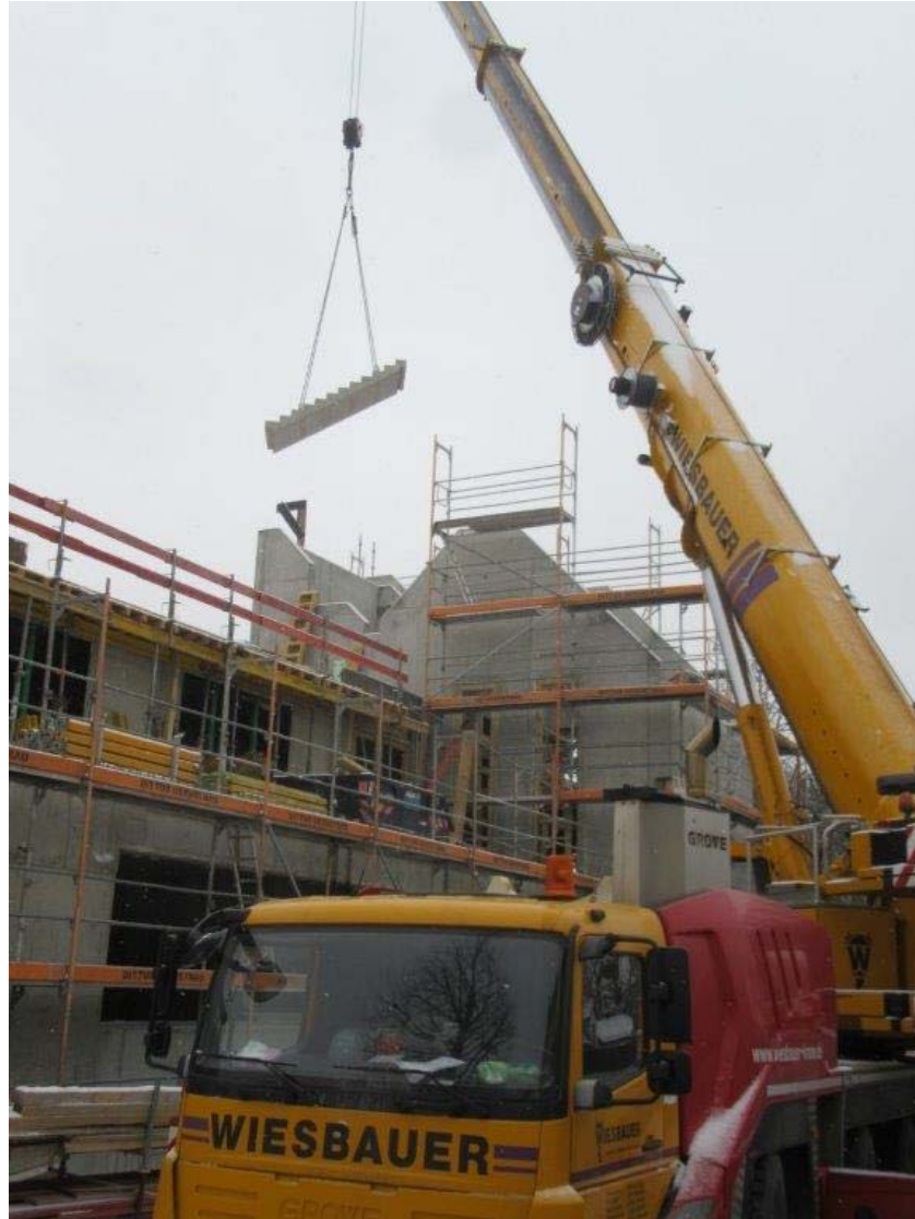
„Beton-Fertigteiltreppen werden mit dem Kran eingebracht“
