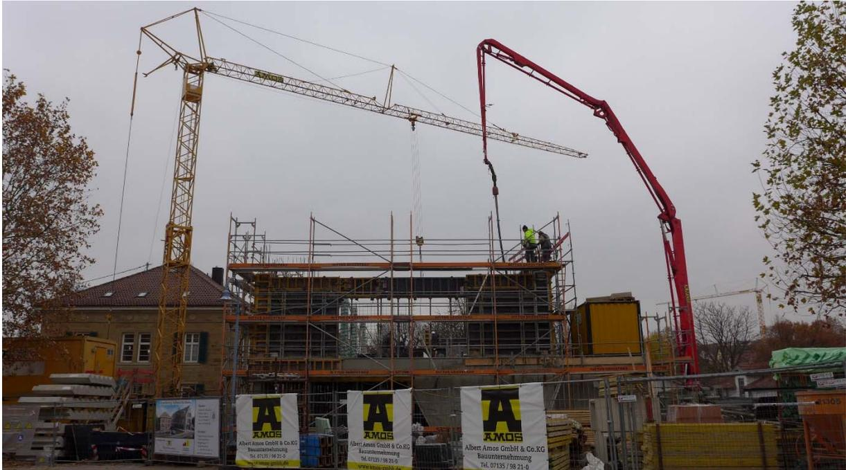
*Mehrmals pro Woche steht die Betonpumpe am Rathausneubau, um abschnittsweise das Material für Wände und Decken in die Schalungen zu befördern.*
