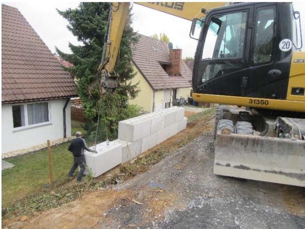
*Mit Hilfe von Betonfertigteilen wird eine provisorische Mauer erstellt, die anschließend hinterfüllt wird, um so eine Aufstellfläche für den Kran zu erhalten.*
