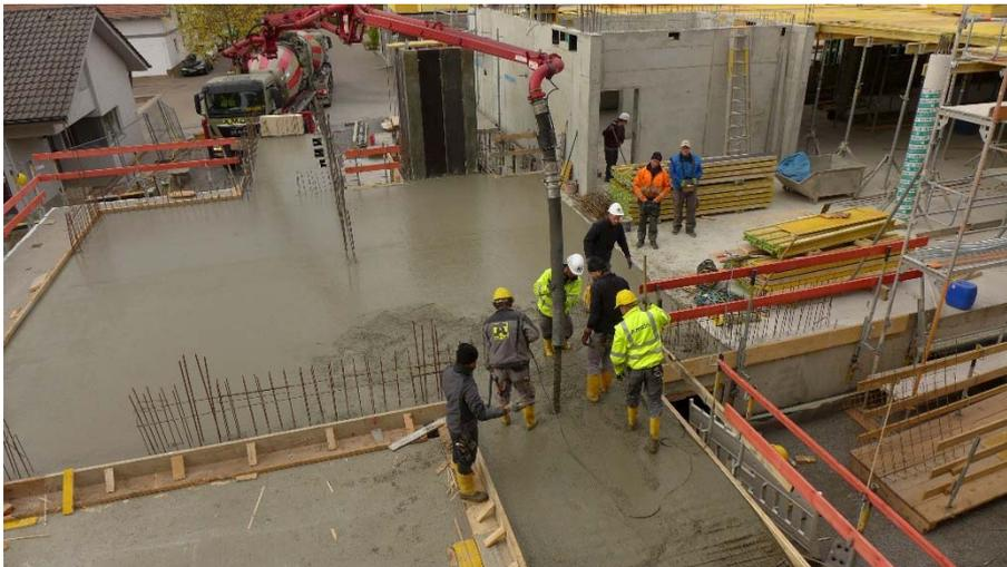
Am Mittwoch wurde mit dem Boden des künftigen Trauzimmers und dem Rest vom Eingangsbereich der letzte Abschnitt der Decke über dem Untergeschoss betoniert.
