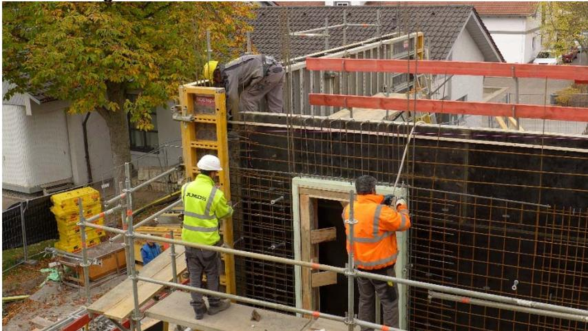
Am Freitagmorgen wird armiert, anschließend die Schalung geschlossen und ...
