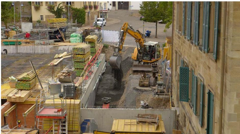
Seit vergangenen Donnerstag wurde die Baustelle zudem durch eine Erdbaukolonne verstärkt, die bereits mit dem Anfüllen und Verdichten des Arbeitsraumes um die neuen Außenwände begonnen hat.
