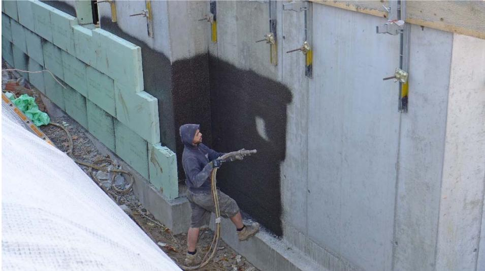
Während auf der Ostseite bereits der Arbeitsraum verfüllt wird, wird an der Nordseite die Isolierung und Wärmedämmung aufgebracht. Hierzu wird zunächst eine bitumenhaltige Dickschicht aufgespritzt, danach Styrodurdämmplatten aufgeklebt, abschließend kommt noch eine Bautenschutzmatte, ehe dann die eigentliche Auffüllung mit Vorsieb erfolgt.
