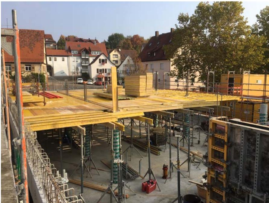
*Teile der Decke über dem Erdgeschoss sind bereits geschalt, so dass in der nächsten Woche die „Eisenbieger“ die Bewehrung einbringen können.*
