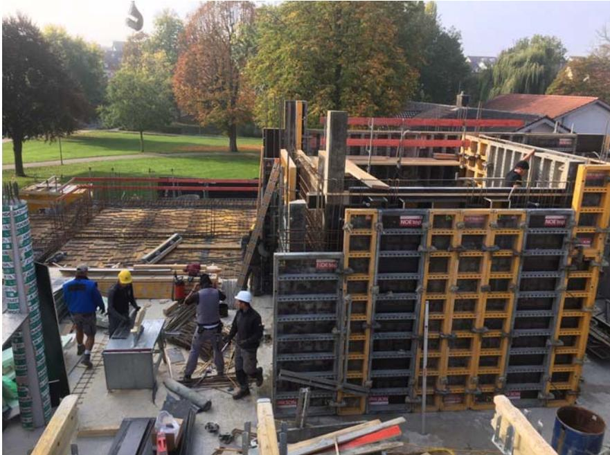
*An der Schalung des Aufzugsschachtes im Erdgeschoss wird letzte Hand angelegt, damit die Wände betoniert werden können.*
