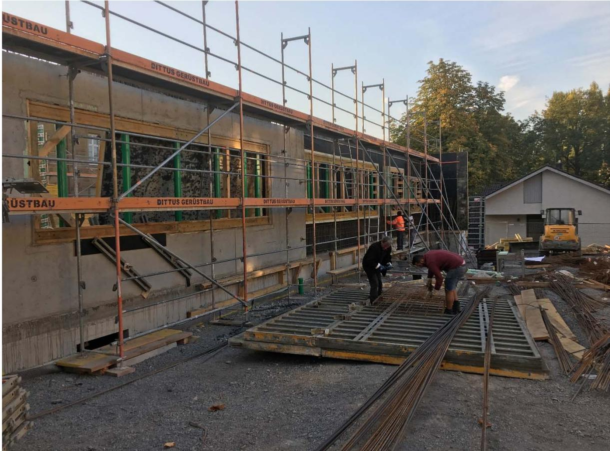
*Erste Wandscheiben der Erdgeschosswand sind bereits betoniert. Die Arbeiten am nächsten Wandabschnitt laufen, zunächst wird eine Wandseite geschalt, dann die Bewehrung eingebracht, ehe die zweite Schalung gestellt und abschließend betoniert wird.*
